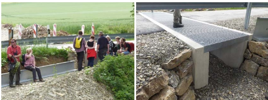
Abb. 27-28: Leiteinrichtung für Reptilien am Durchlass ungewöhnlich: ein eigens geschaffener Reptiliendurchlass
