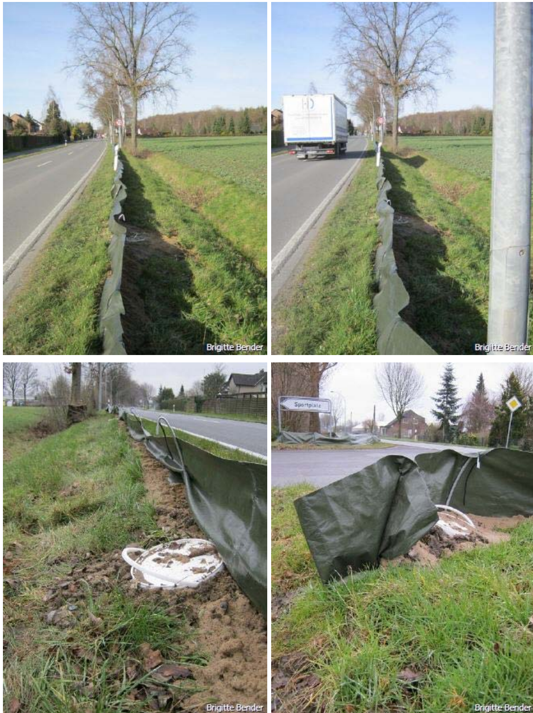
Abb. 1-4: Folienzäune direkt am Straßenrand sind starken Belastungen ausgesetzt. Senkrecht gestellt behindern sie die Rückwanderung der Amphibien. Fotos: Biggi Bender
