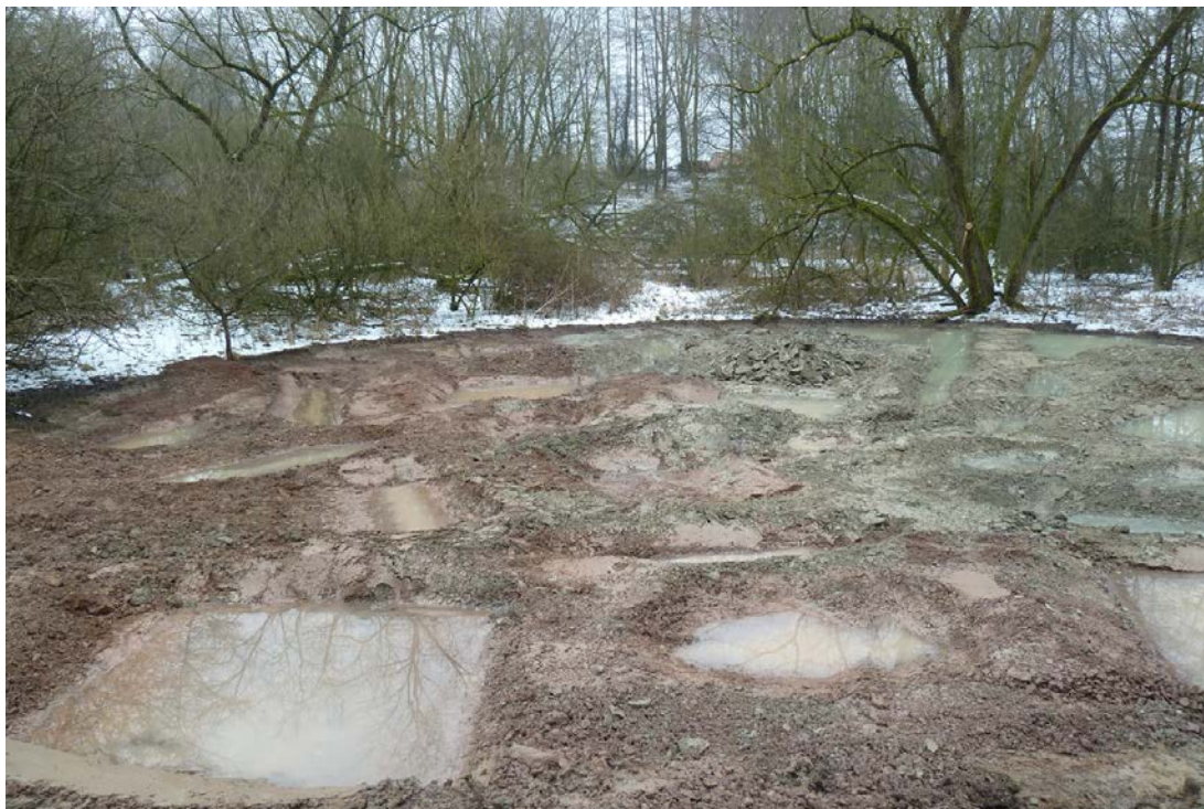
Abb. 4: Februar 2013: Ein unter Baggereinsatz angelegtes Tümpelfeld. Foto: Mirjam Nadjafzadeh.
